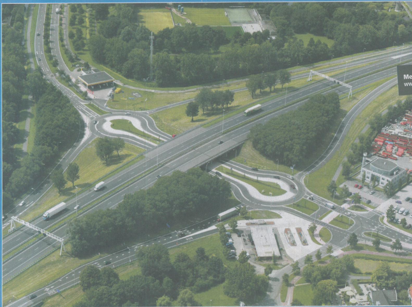
Luchtfoto van de Hondenbot rotonde afrit 7 A20, Maasland/Maasvluis. Van der Waal en Partners deed de engineering.
