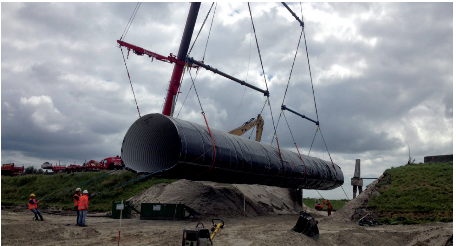
Inhijzen fietstunnel in N222
